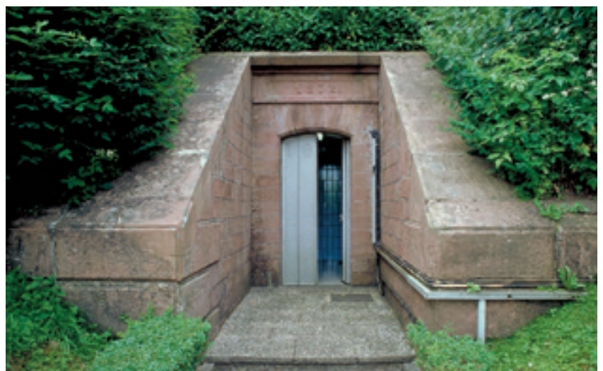
Eine der ältesten Hessenwasser-Anlagen: Eingangsportal zur Quellwassergewinnung in Birstein-Fischborn von 1872
