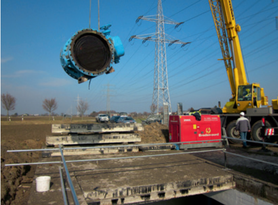
Risikobasierte Instandhaltung: Ausbau einer über vierzig Jahre alten Absperrarmatur der Riedleitung im Jahr 2011
